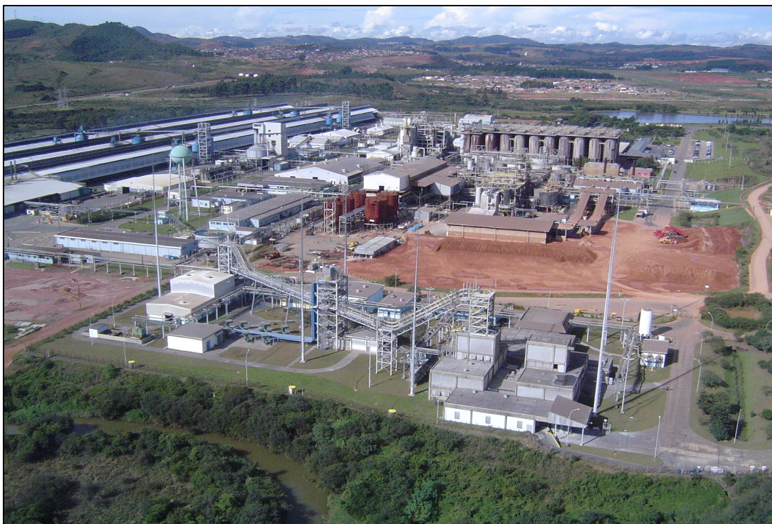
Figura 5: Vista aérea da Fábrica da Alcoa em Poços de Caldas - MG
